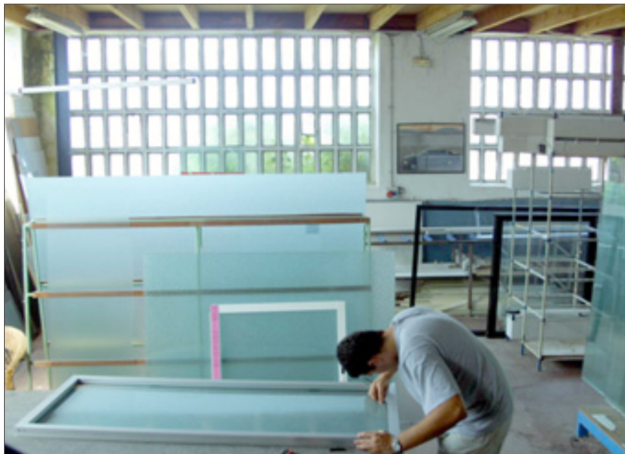
Trabajos de montaje de estructuras de la cooperativa de 'Reto'.
